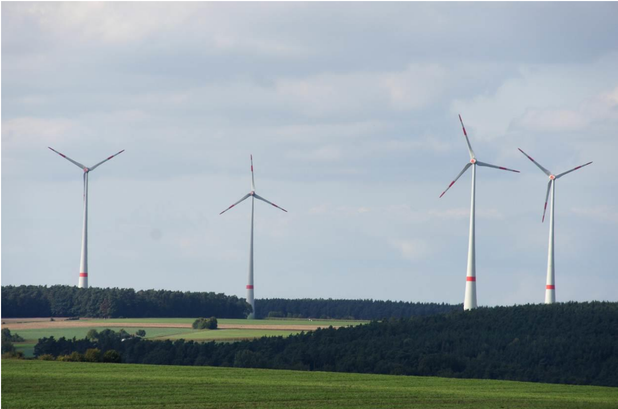
Anlagen der WUW – Windanlage Wilhermsdorf-Unterulsenbach und der Bürgerwindenergie Wilhermsdorf
