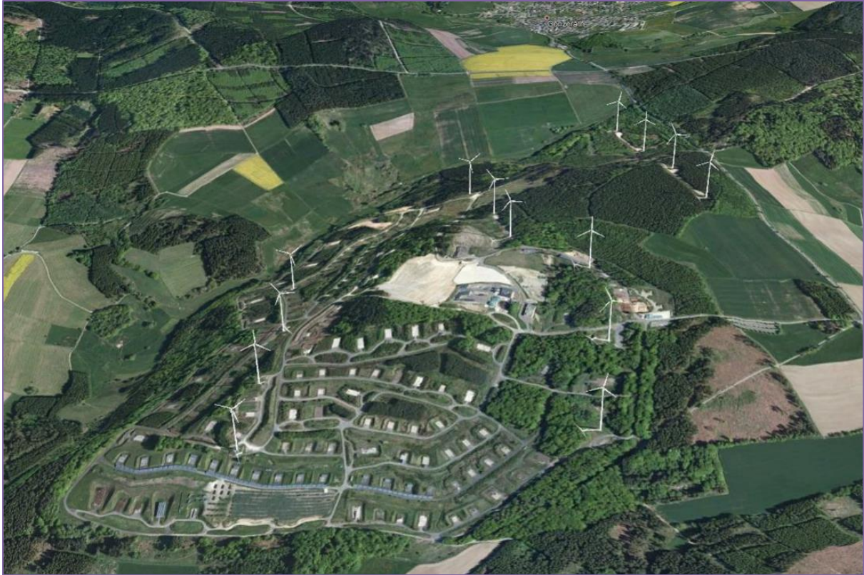
Windpark Morbach Bestand mit 14 Windenergieanlagen, die zurückgebaut werden (Quelle: wivi consult GmbH & Co. KG)
