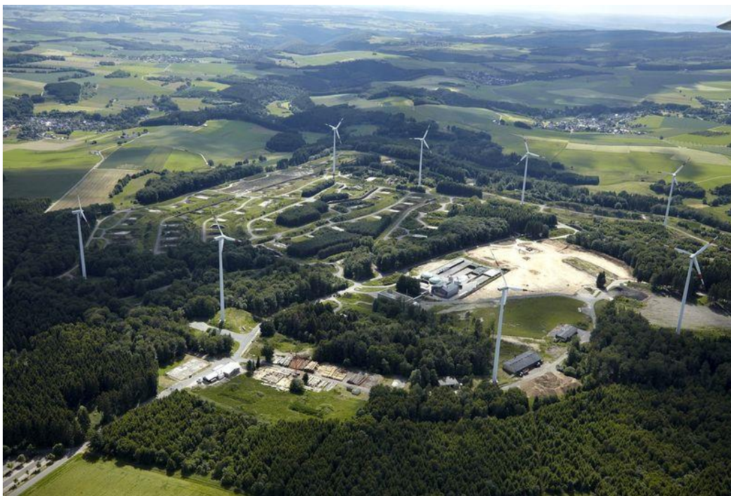
Bestandwindenergieanlagen der Morbacher Energielandschaft (Quelle: DDInfo.de)
