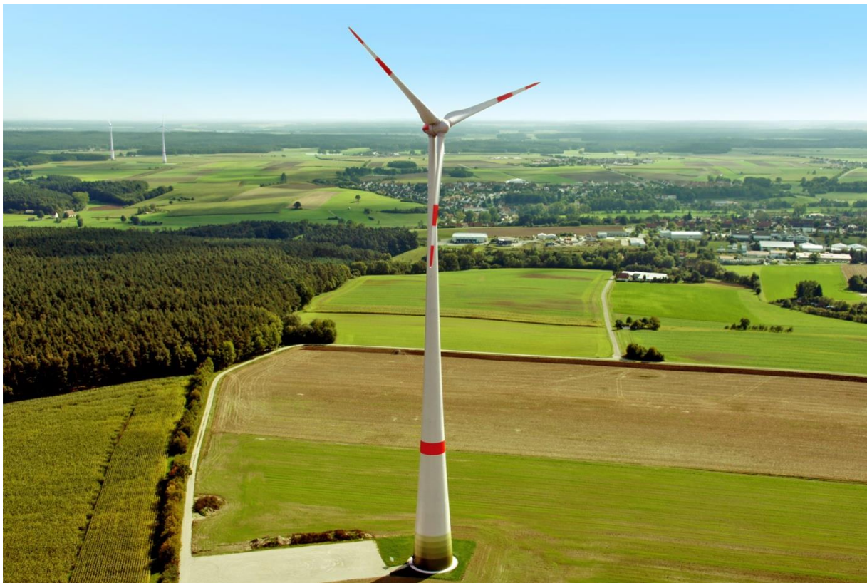
Anlage ENERCON E-82 der Bürgerwindenergie Wilhermsdorf
