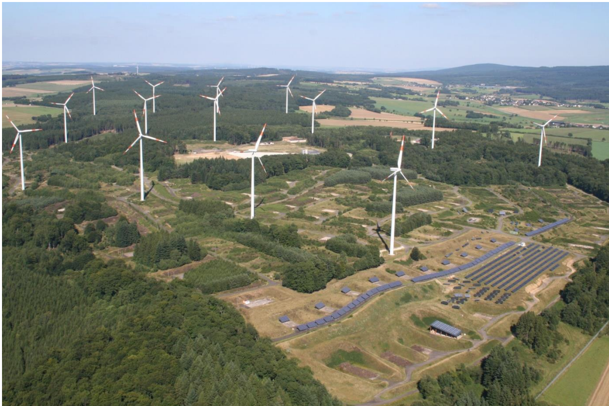
Bestandsanlagen der Morbacher Energielandschaft, die im Wege des Repowerings abgebaut werden (Quelle: Gemeinde Morbach)
