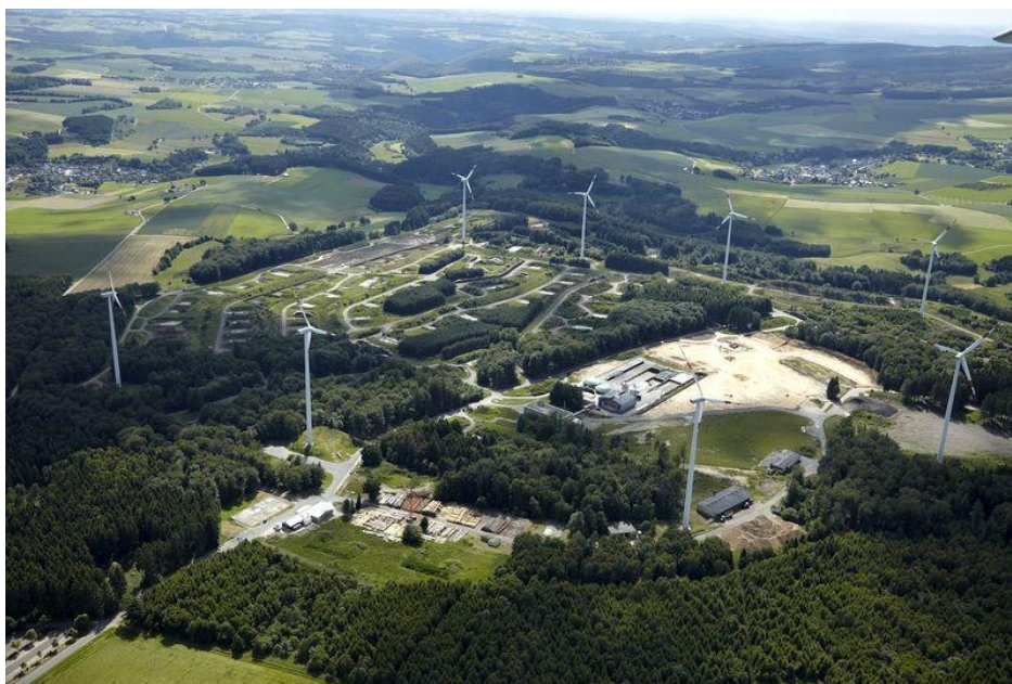
Bestandwindenergieanlagen der Morbacher Energielandschaft (Quelle: DDInfo.de)
