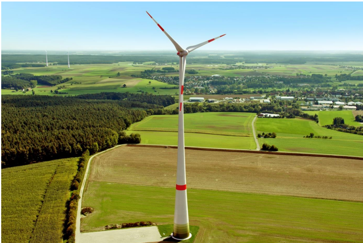
Anlage ENERCON E-82 der Bürgerwindenergie Wilhermsdorf
