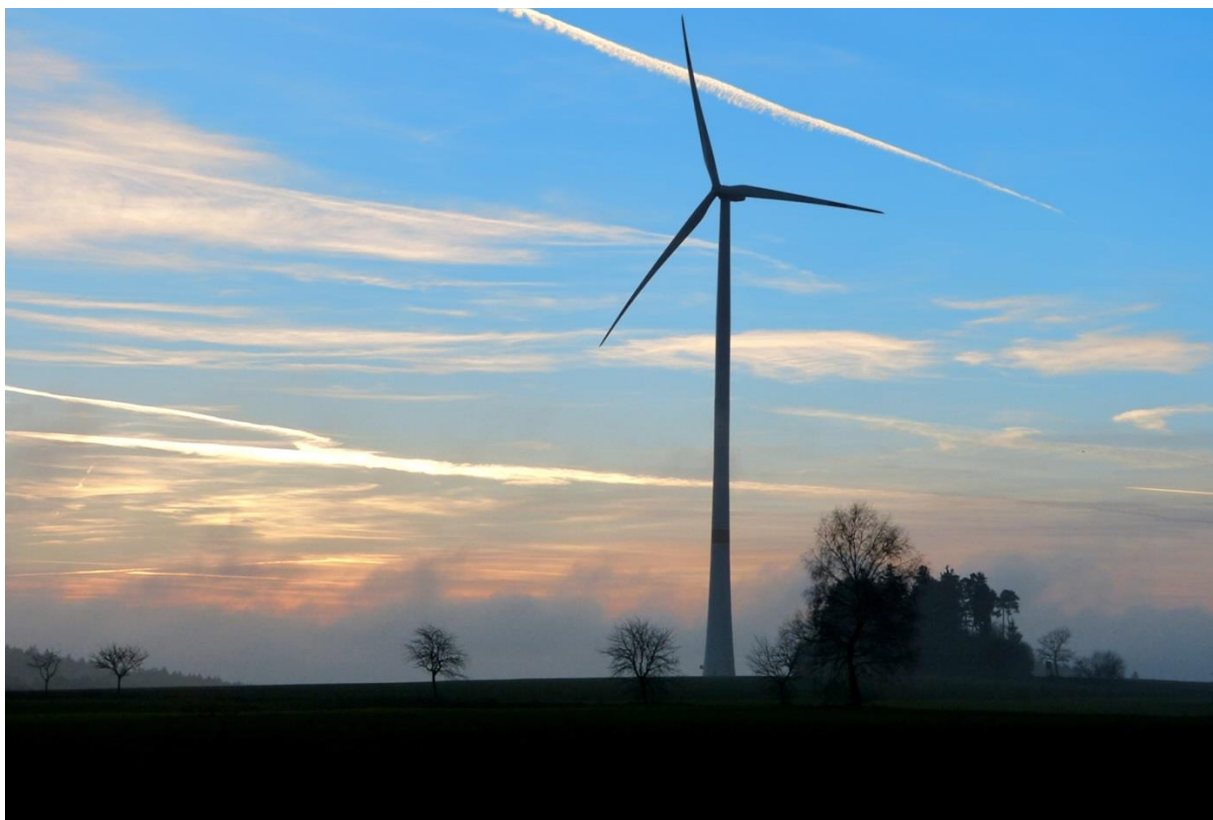
Anlage der Bürgerwindenergie Hoher Weg GmbH & Co. KG (Nordex N117 – 2,4 MW)
