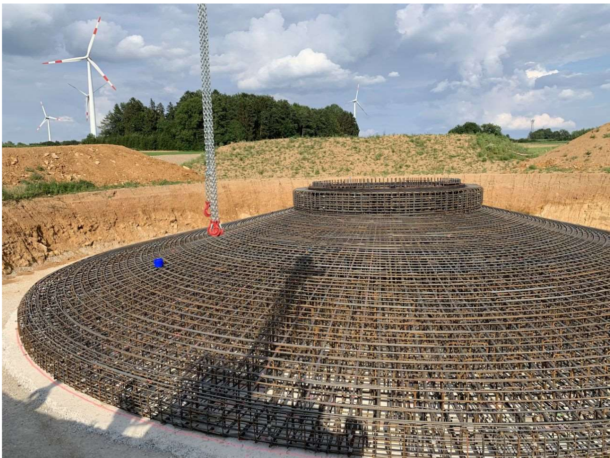
Fundament für eine Windenergieanlage Vestas V 136 der Bürgerwindenergie Altdorf Eismannsberg
